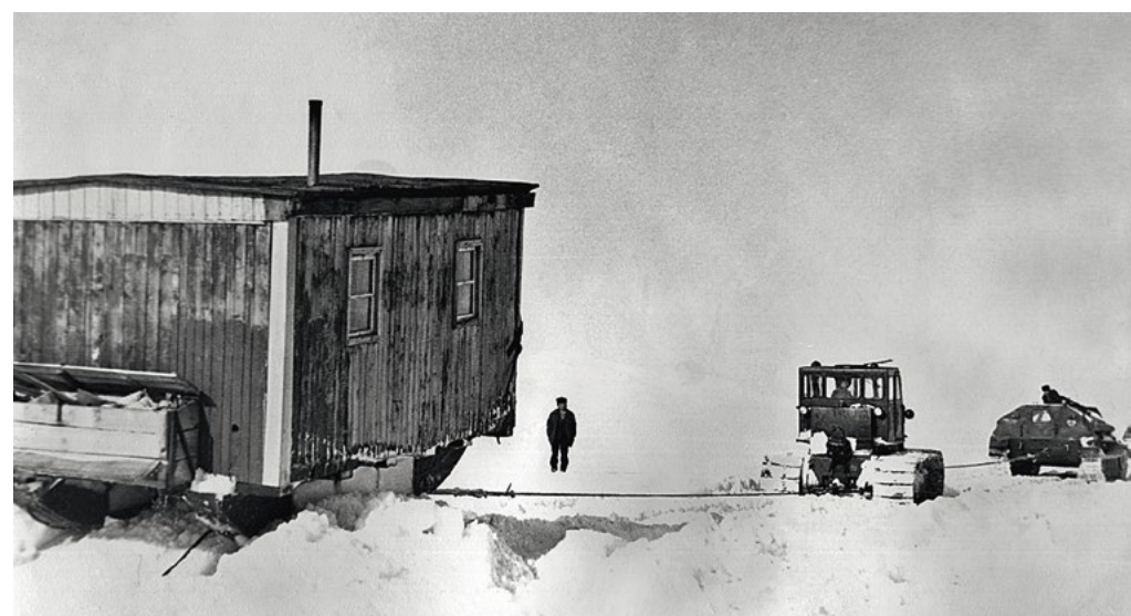
Фото 3. Пролив Чечекуиым. Чтобы протащить балок через глубокую наледь, приходится в помощь трактору Т-100 подцепить два ГТТ
